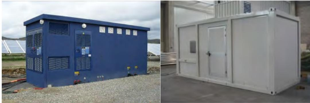
*Exemples d'onduleurs et transformateur installés dans postes béton et containers*
